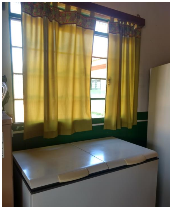
Foto 06 – Janelas sem proteção
